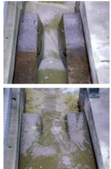
Abb. 6: Venturi-Messstrecke im Kanalnetz bei Trockenwetter (oben) und überströmt bei Regenwetter (unten)
