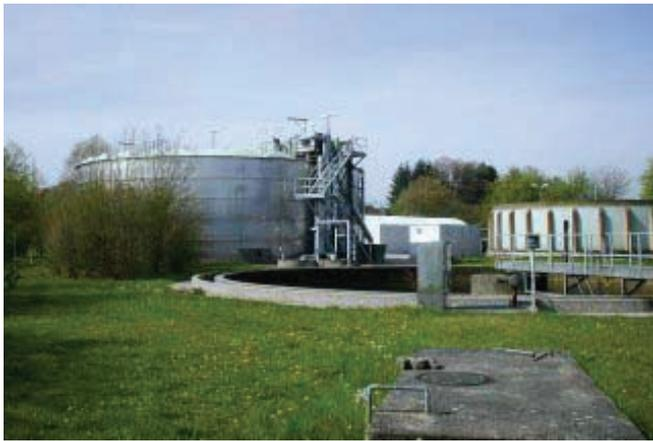
Abb. 1: Das neue Modul in Stahlbauweise
