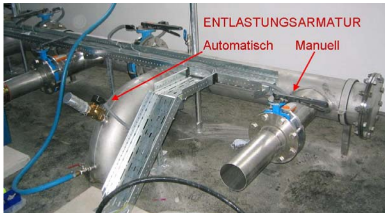
Abbildung 3: Installation zur Entspannung auf Umgebungsdruck
