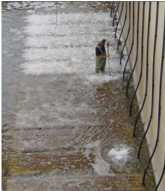
Abbildung 4: Mechanische Reinigung von Belüfterplatten
