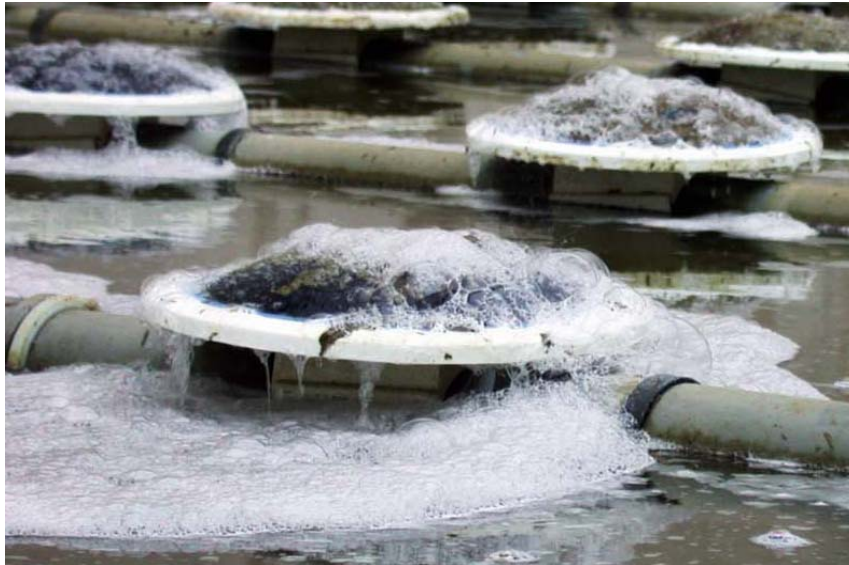
Abbildung 11: Ausströmen der Reinigungsflüssigkeit
