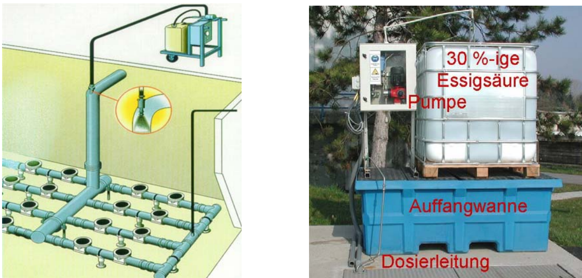
Abbildung 5: Ameisensäuredosierung und Essigsäureeindüsung
