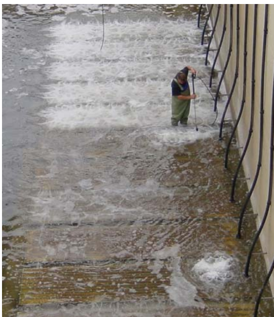
Abbildung 7: Mechanische Reinigung von Belüfterplatten
