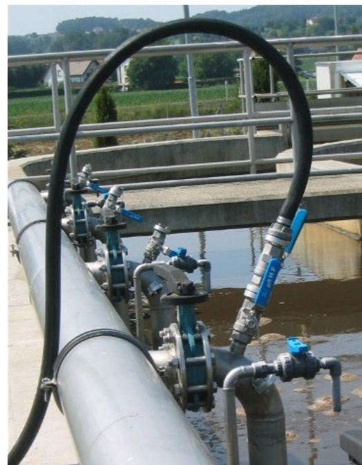
Abbildung 10: Anschlussstutzen zur Einbringung der Reinigungslösung
