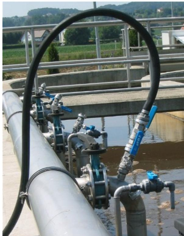
**Abbildung 16:** Anschlussstutzen zur Einbringung der Reinigungslösung
