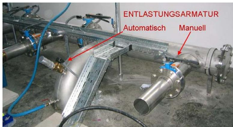
**Abbildung 12:** Installation zur Entspannung auf Umgebungsdruck
