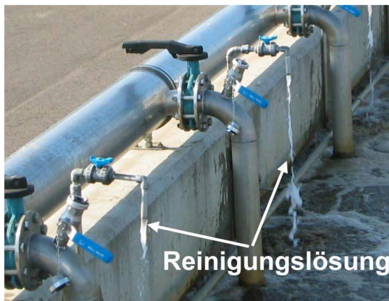
**Abbildung 18:** Entleerung über die Entwässerungsleitungen
