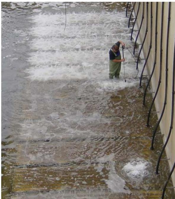
In der Abbildung 13 erkennt man deutlich den Reinigungseffekt und einen Defekt an einer Platte.
