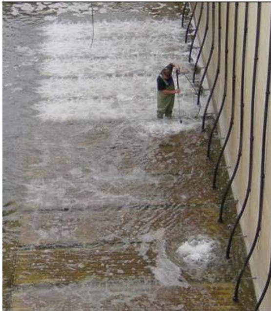
**Abbildung 4:** Mechanische Reinigung von Belüfterplatten
