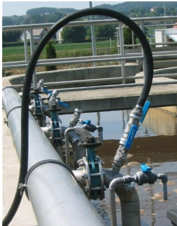
**Abbildung 16:** Anschlussstutzen zur Einbringung der Reinigungslösung
