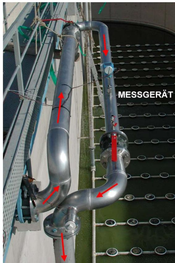
**Abbildung 12:** „Mobile“ Luftvolumenstrommessung
