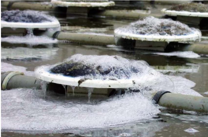
**Abbildung 8:** Ausströmen der Reinigungsflüssigkeit
