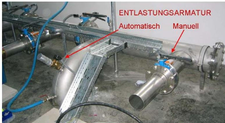
**Abbildung 3:** Installation zur Entspannung auf Umgebungsdruck
