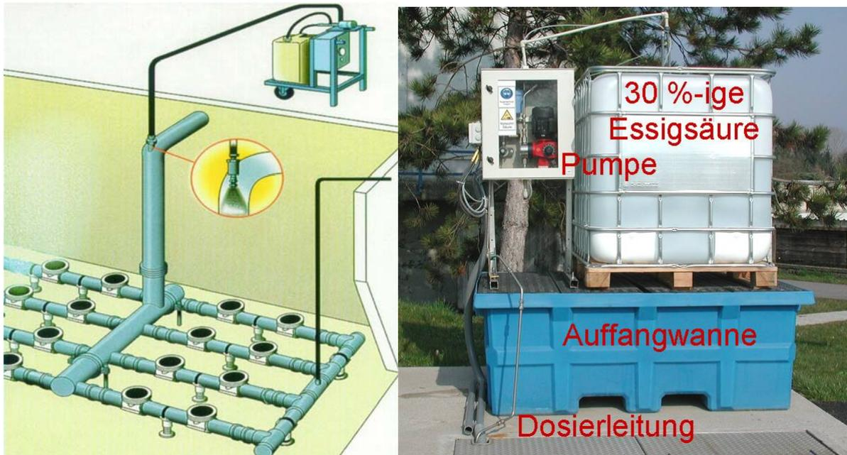
**Abbildung 2:** Ameisensäuredosierung und Essigsäureeindüsung
