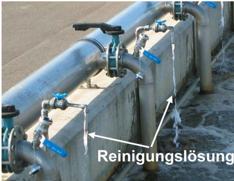
Abbildung 17: Entleerung über die Entwässerungsleitungen
